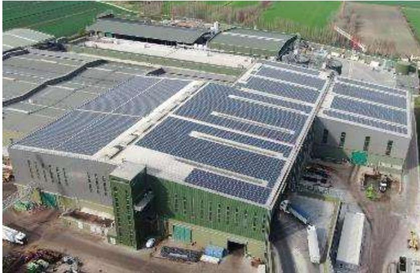
Nel corso del biennio 2023/2024 sono stati installati sulla copertura dei fabbricati siti nel polo impiantistico ulteriori impianti fotovoltaici, destinati al proprio autoconsumo, tuttora in attesa di attivazione da parte di Enel:
